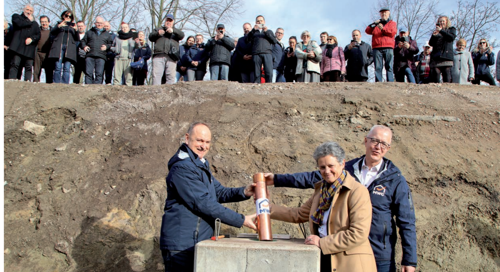
Landesministerin Dr. Lydia Hüskens versenkt gemeinsam mit den MWG-Vorständen Thomas Fischbeck und Dr. Andreas Hartung eine Zeitkapsel mit wichtigen Dokumenten. Zahlreiche Gäste verfolgen das Geschehen am Rande der Baugrube.
